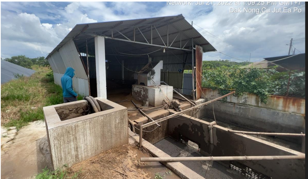
Hình 3.14: Hình ảnh bể gom phân, máy tách phân, nhà chứa phân của trại.
