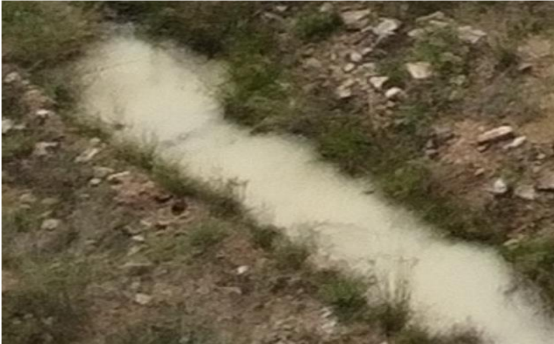
Hình 3.4: Hình ảnh mương thoát nước mưa của trang trại
