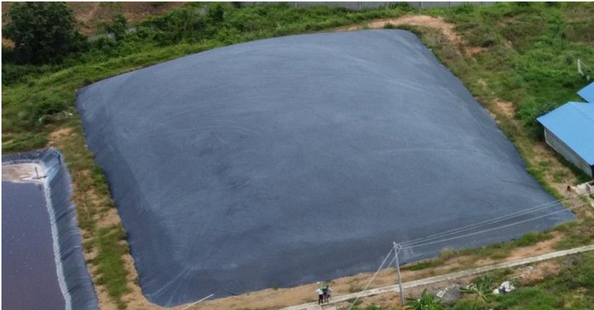
Hình 3.8: Hình ảnh hầm Biogas
