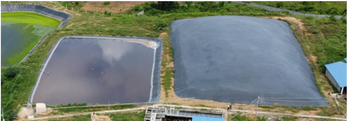
Hình 3.9: Hình ảnh Hồ điều hòa sau Biogas
