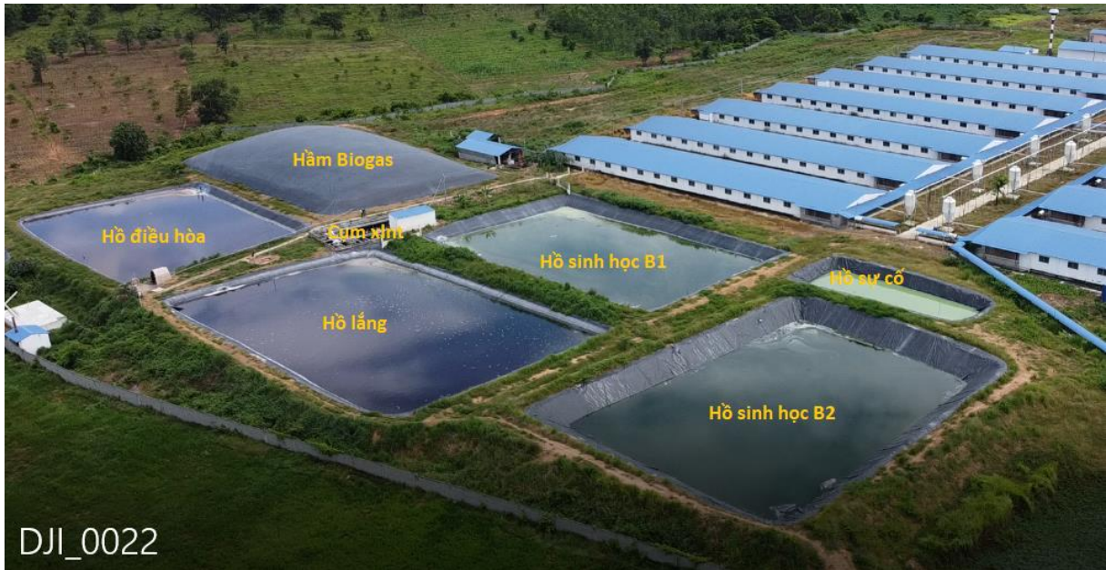
Hình 3.7: Hình ảnh hệ thống xử lý nước thải tập trung của trang trại
