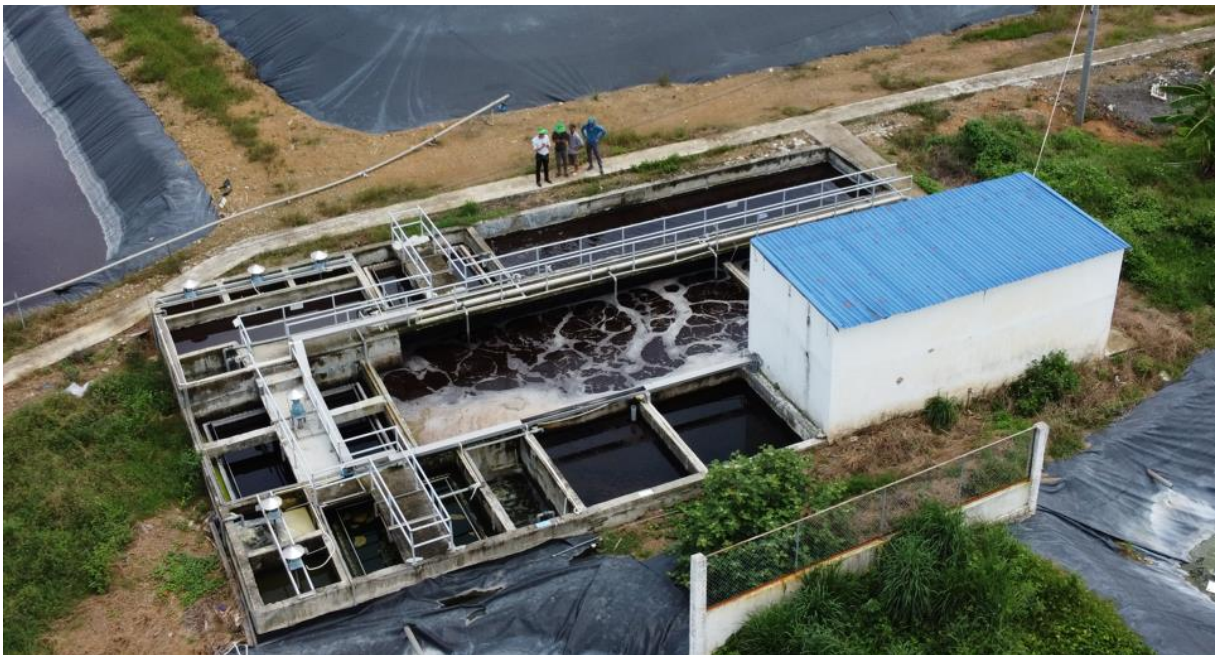
Hình 3.10: Hình ảnh cụm xử lý nước thải sau biogas
